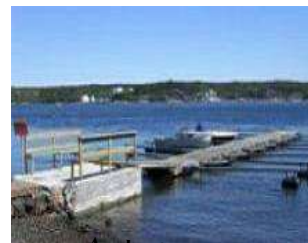
Aanleg Steiger Foto www.sjohaug.no
